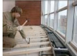
17) Произвести при необходимости окончательную регулировку болтов для установки лаг на требуемый уровень. Перепад заданного уровня выставленных лаг должен составлять не более 2 мм на 2 пог. м. При этом недопустим поворот закрепленного болта более чем на 45°.
