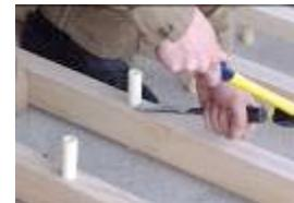
19) Проверить жесткость крепления болтов к основанию нажатием на каждую лагу и попыткой оторвать ее от основания (боковое расшатывание не применять).
