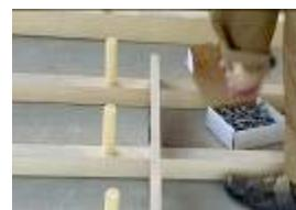
13) Утопить дюбель-гвозди в просверленные отверстия через два крайних болта лаги при помощи добойника ударом по шляпке дюбеля.
