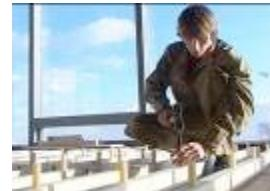
14) Выставить лагу на заданную высоту, вращая два крайних болта шестигранником, используя при этом уровень (угольник и лазерный нивелир). Заданная высота подъема лаги определяется как разница между самой высокой точкой, определенной по правилам п. 6.2. настоящей Инструкции и толщиной настила (настилов) и напольного покрытия.
