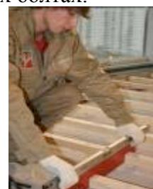
23) На установленные лаги укладывается первый слой настила. Необходимо разложить целые листы настила на лаги с зазором между собой со всех сторон не более 3-10 мм и отступами от стен не более 10-20 мм.
