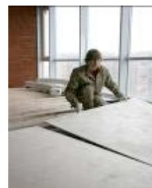
27) Разложить целые листы второго слоя настила (внахлест стыкам первого слоя не менее чем на 300 мм.) и прикрепить их к первому слою, используя саморезы по дереву 3,5\*32 мм в количестве 40-60 шт. на м<sup>2</sup>. Шаг между саморезами должен быть не более 150 мм. Второй настил рекомендуется укладывать при толщине первого настила менее 18 мм.
