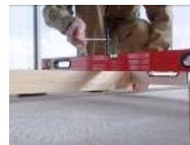
15) Повторно утопить дюбель-гвозди двух крайних болтов добойником и забить их путем удара по шляпке гвоздя.
