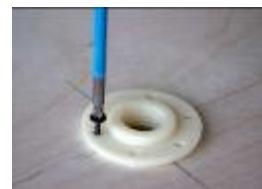
8) Шестигранником вкрутить в резьбовые отверстия втулок болты при помощи шуруповерта или перфоратора, так чтобы закрытый торец каждого болта, пройдя через резьбовое отверстие втулки, вышел из нее примерно на одинаковое расстояние. Разложить целые листы и вставки плит на основание втулками вниз. Таким образом, каждая плита или вставка будет стоять на основании, как «табуретка на ножках».
